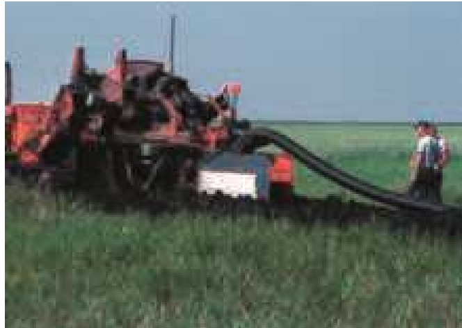
Scavando trincee per installare il sistema di drenaggio in Iowa durante gli anni 80.
